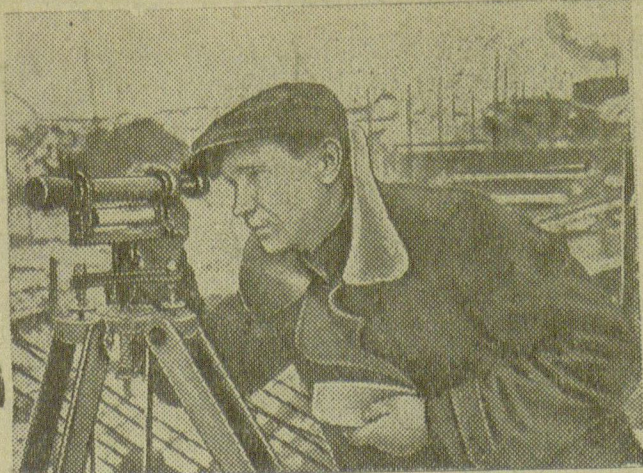
На головном сооружении. На снимке: сменный прораб тов. Калюжный у нивелира.
