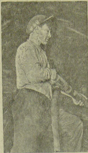
Стахановец-проходчик тоннеля А. Попов.
